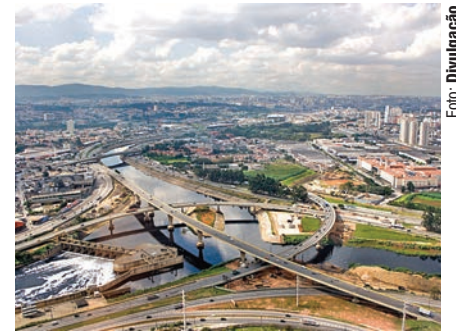
Tratamento de esgoto ainda é item a ser melhorado
