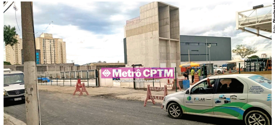
Tapumes foram retirados na estação Santa Marina
